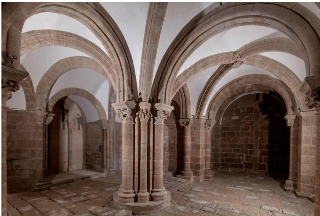
Figura 4. Cripta do Pórtico da Glória (c. 1168). “Entre a cabeceira da Catedral de Santiago e a Praça do Obradoiro existe um grande desnível, que Mestre Mateo decidiu corrigir com uma cripta, algo inédito na Galiza da época. Ela está organizada por um grande pilar central com oito colunas geminadas de onde partem os arcos das abóbadas que, por sua vez, se encontra abaixo do Trumeau do Pórtico (...) Sua planta reproduz a da própria Catedral, o que se verifica sobretudo nas cinco capelas ao redor do deambulatório, das quais a central segue o modelo da capela do Salvador .” – Google Arts & Culture .
